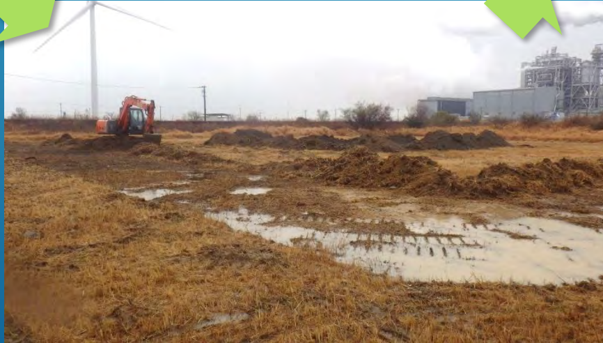
重機による伐根（環境省生物多様性保全推進支援事業）
