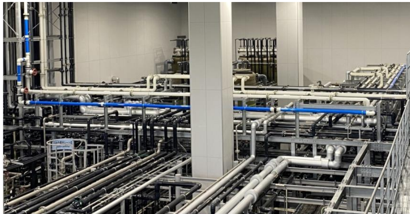
参考：本資料の実証試験を実施したKIHの超純水製造装置（青色配管が実証中の配管）
