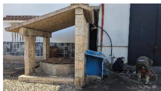
ボーリング孔洗浄作業
