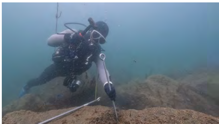
スポアバッグ固定用のペグ打ちの様子
