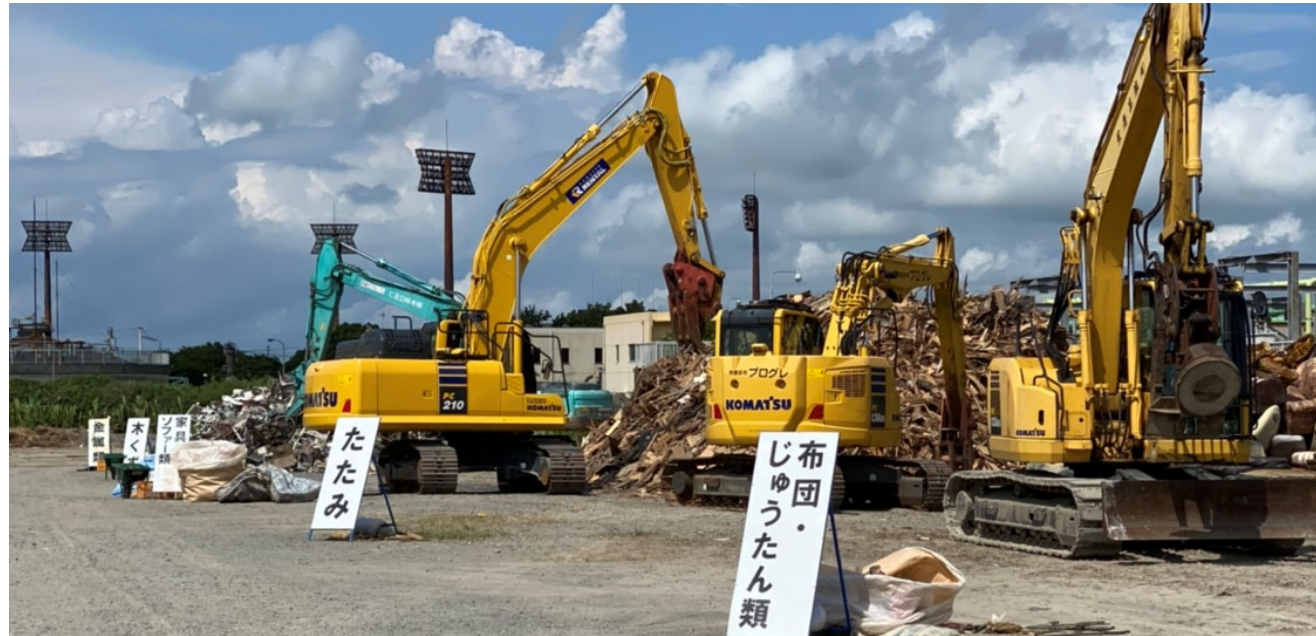
【仮置場全景写真】
