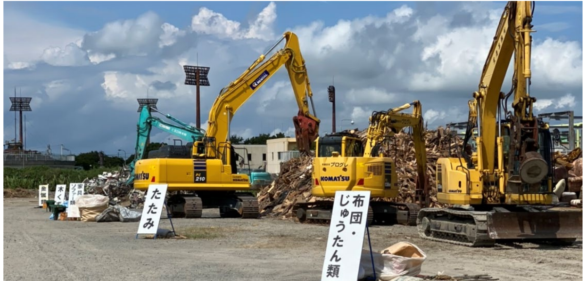
【仮置場全景写真】
