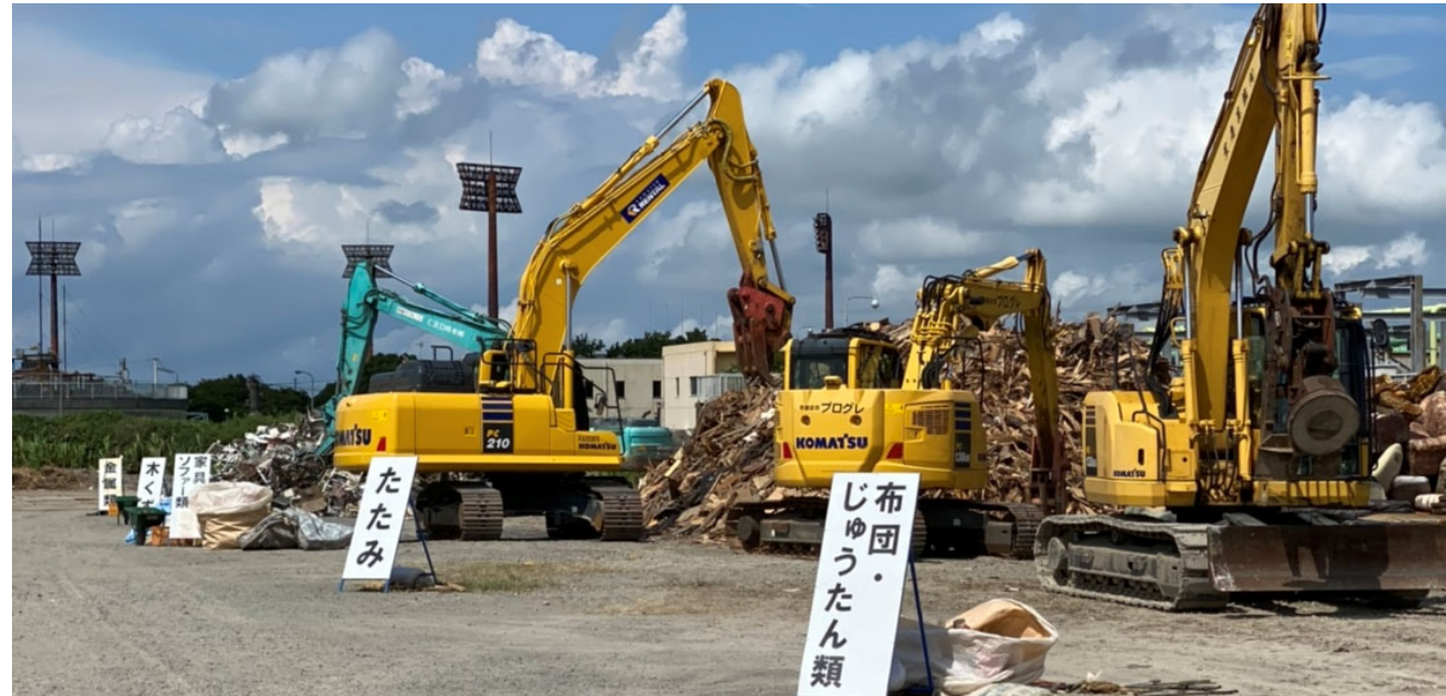
【仮置場全景写真】
