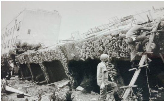
新潟市撮影：県営住宅倒壊
