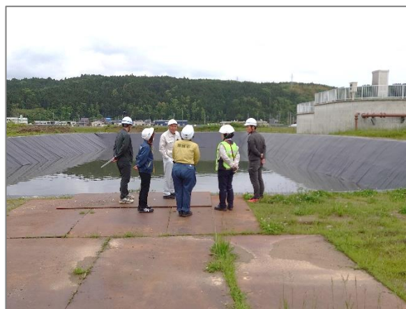
志賀町浄化センター
