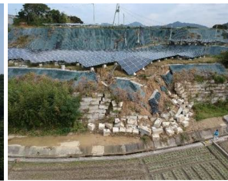
法面保護工が崩れて流出した事例
