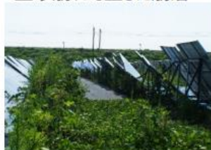
放置されたパネルの現況
