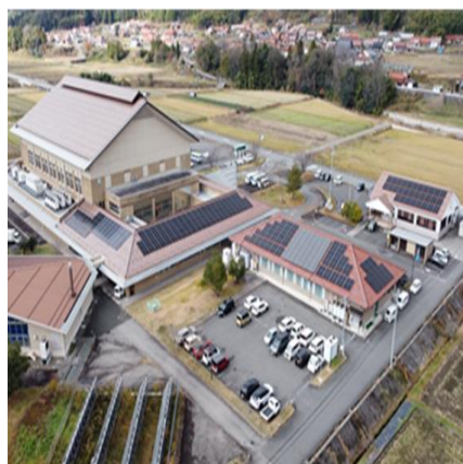
公共施設に導入された太陽光発電
