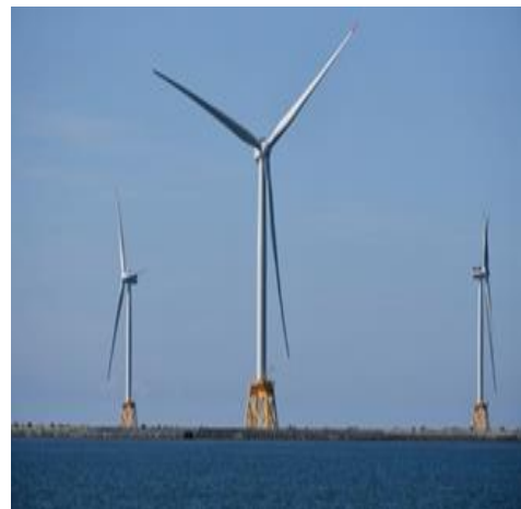
石狩湾新港洋上風力発電所
