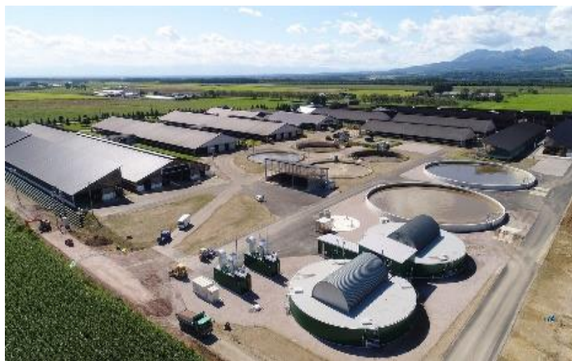
バイオガスプラント
