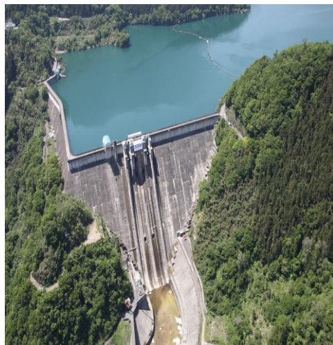
県内の水力発電所
