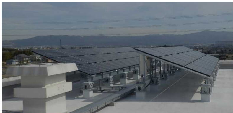
県有施設への太陽光パネル設置
