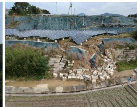
法面保護工が崩れて流出した事例
