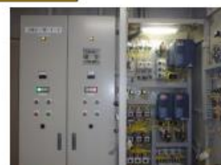
給排気ファンのインバータ制御
