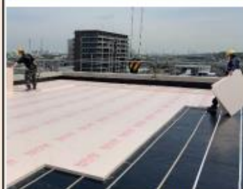
屋根の高断熱化
