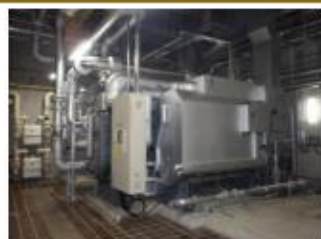
高効率ガス吸収式冷温水機
