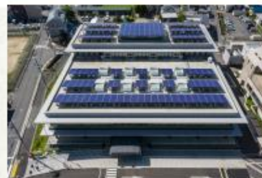
太陽光発電(159kWh)
