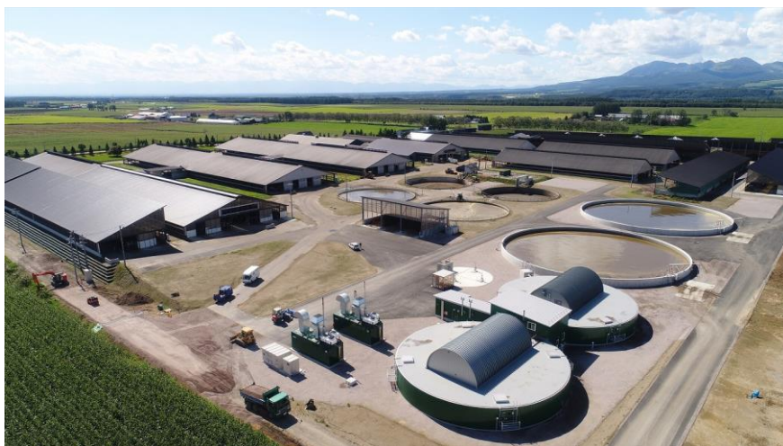
バイオガスプラント
