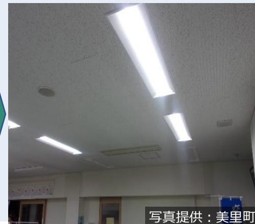
<蓄電池使用時>
