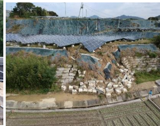
法面保護工が崩れて流出した事例
