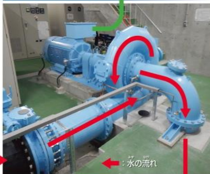
発電時の水の流れ
