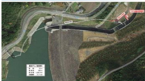
発電所（上空からの写真）
