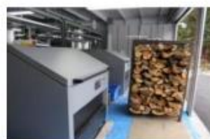
PYROMAT ECO 151 170kW 2基 湯〜とびあ黄金泉 国民宿舎あわくら荘
