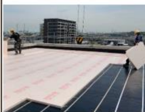
屋根の高断熱化
