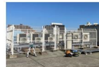
改修後の空調・換気設備
