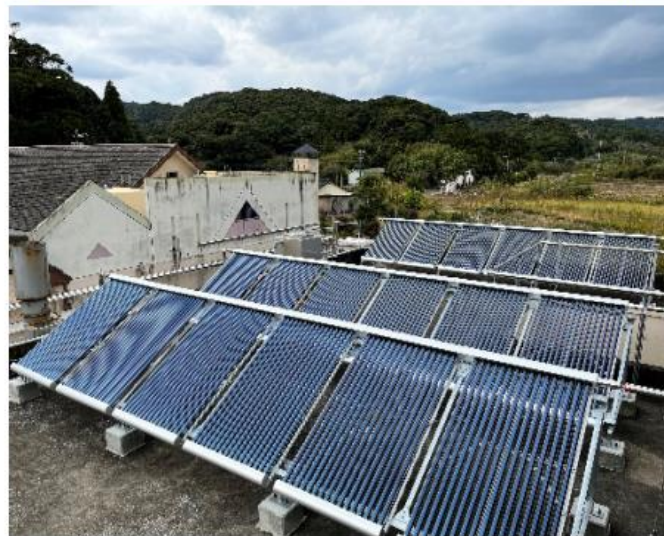
温泉センター屋根に設置された太陽集熱機器
