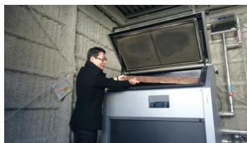
木質ボイラー
