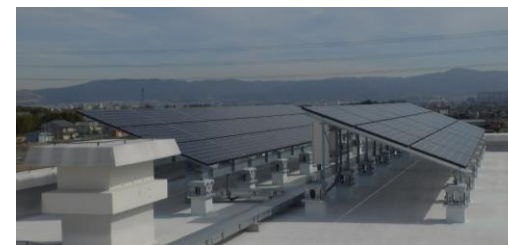
県有施設への太陽光パネルの設置
