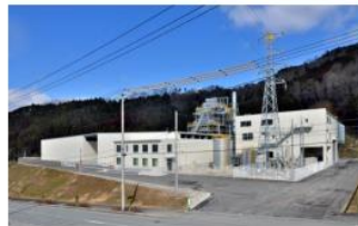
真庭バイオマス発電所 (出力10,000kW)
