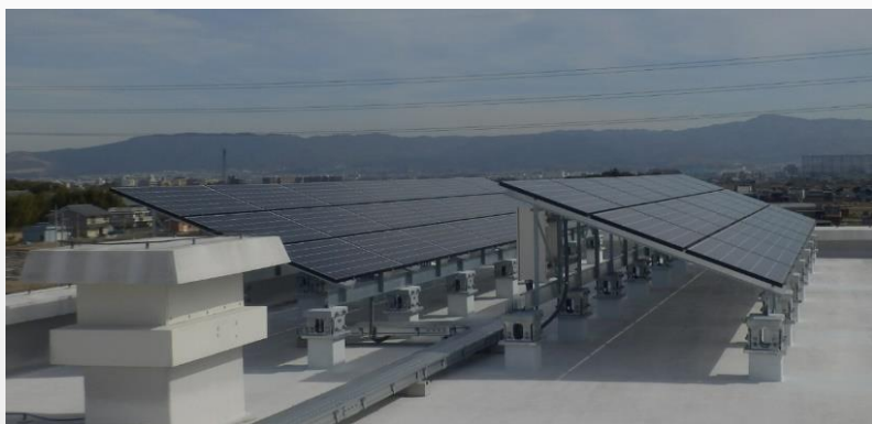
県有施設への太陽光パネル設置
