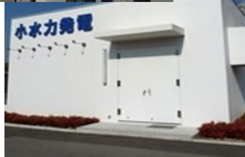
上水道の小水力発電
