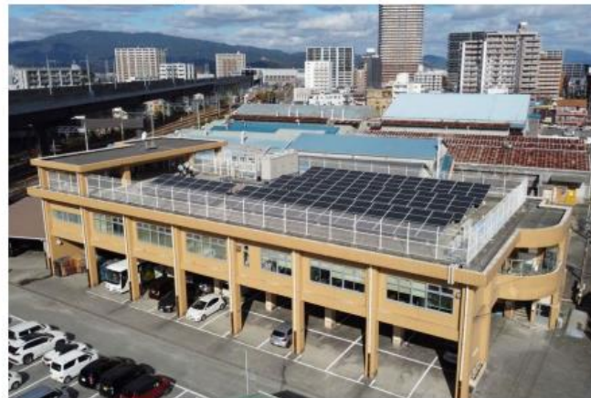
環境部庁舎全景
