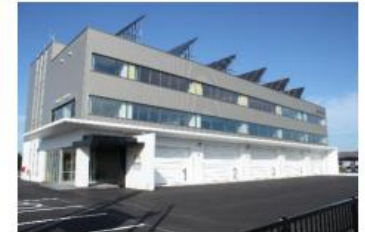
導入施設: 白糠消防庁舎
