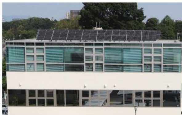
太陽光パネルの設置
