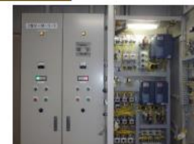
給排気ファンのインバータ制御
