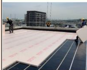
屋根の高断熱化
