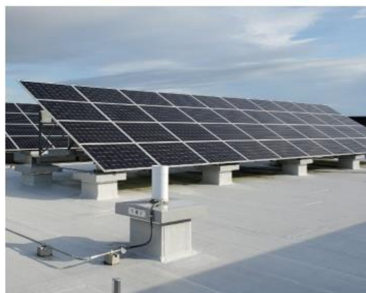
太陽光パネルの設置
