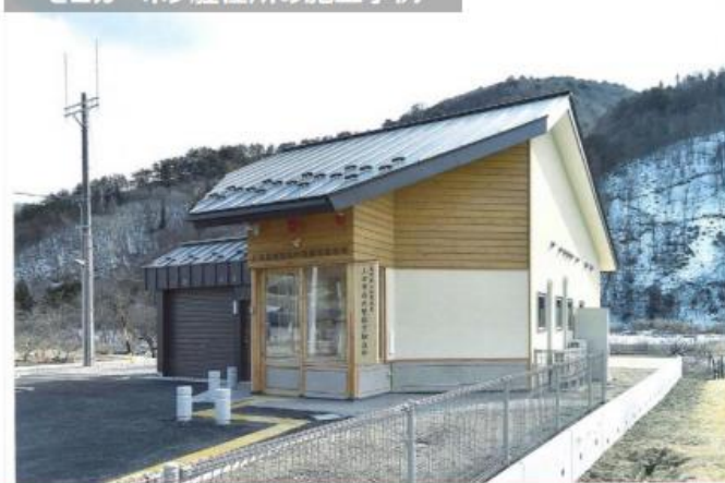
ゼロカーボン駐在所の施工事例
