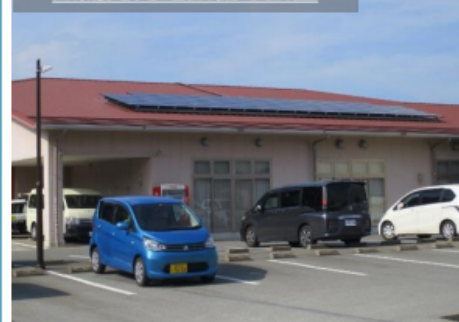
太陽光発電設備の設置
