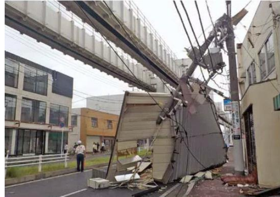
道路上に倒壊したプレハブ
