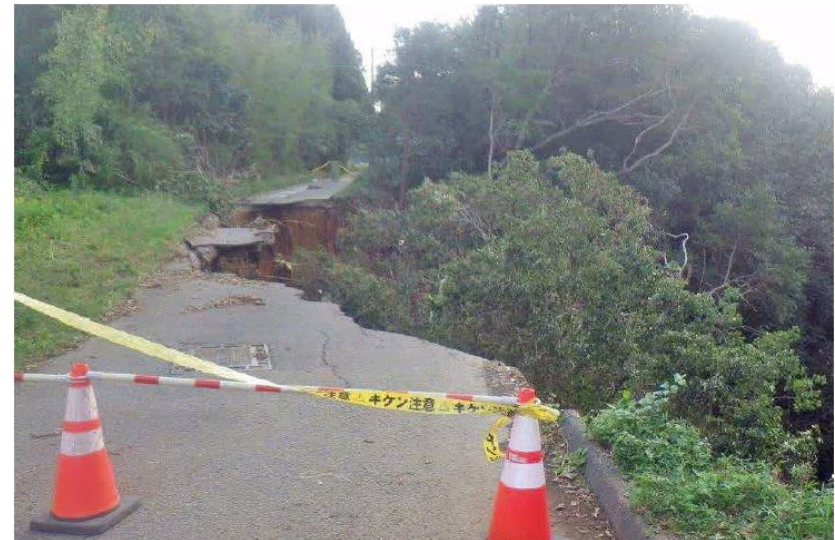
崖崩れにより分断された道路
