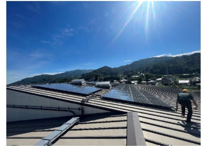
公共施設PPA事業に向けた屋根調査（エネルギー事業者が事業実施予定）
