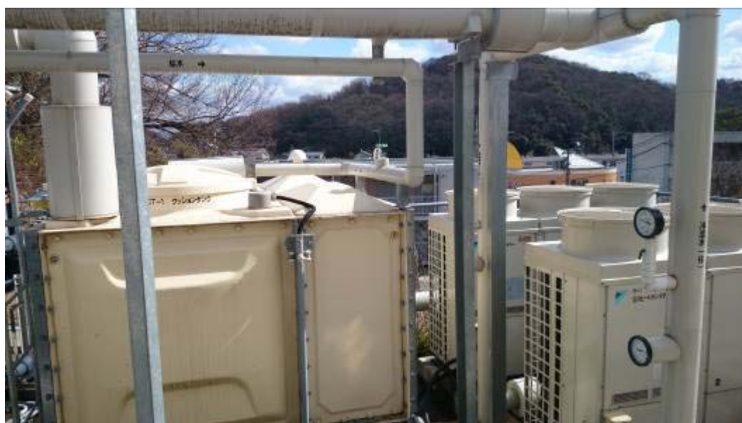
図 46 好適環境水の保温用熱源(空冷ヒートポンプチラー×2台:右)
