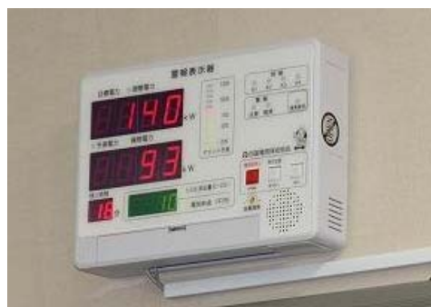
県有施設に設置されたデマンド監視装置 【写真】愛媛県職員ブログより
