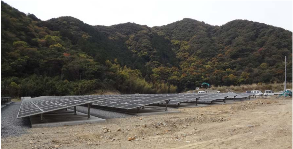
図 38 下益野地区の太陽光発電システム設置状況
