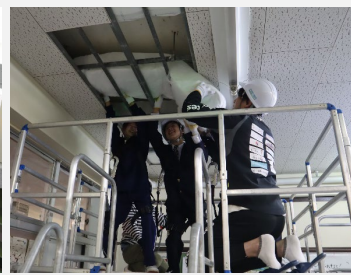
天井裏へ断熱材設置
