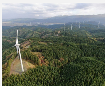
上空から見た風力発電設備
