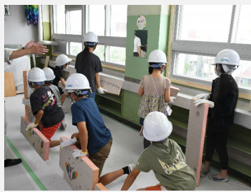
外壁の内側への断熱材設置
