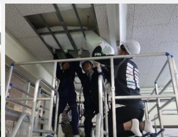
天井裏へ断熱材設置
