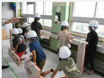
外壁の内側への断熱材設置
