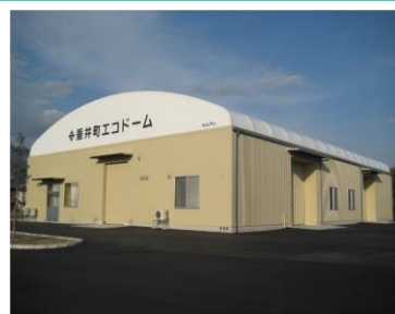
垂井町エコドーム 再資源化事業者
