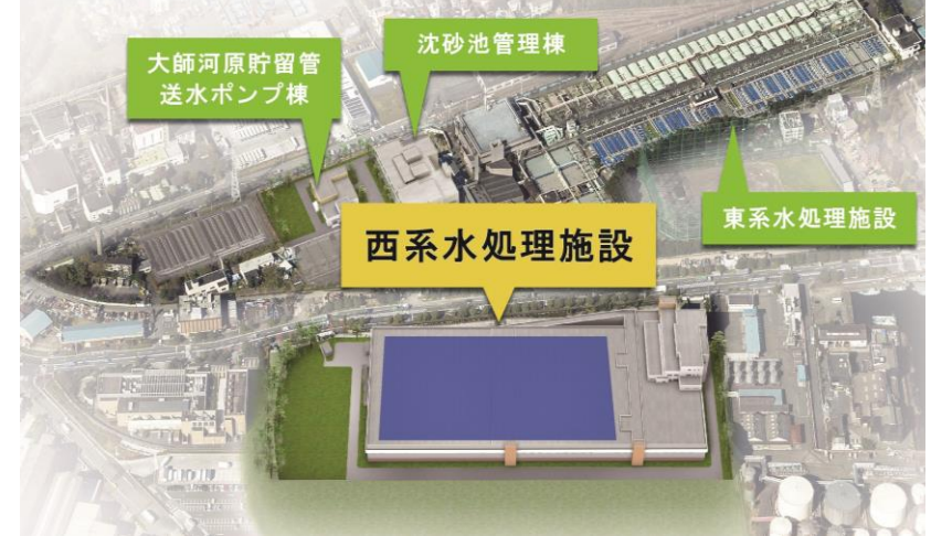
入江崎水処理センター
