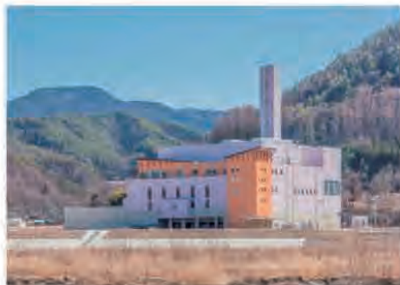
電源調達先の上伊那クリーンセンター
