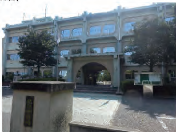
電力供給先 (肝付町役場本庁舎)
