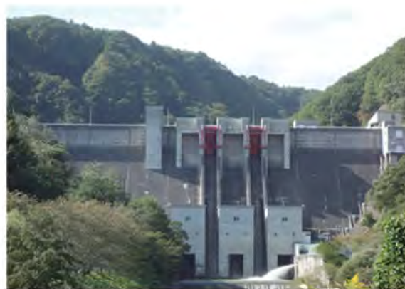
岩手県企業局管理/滝発電所（水力発電）
