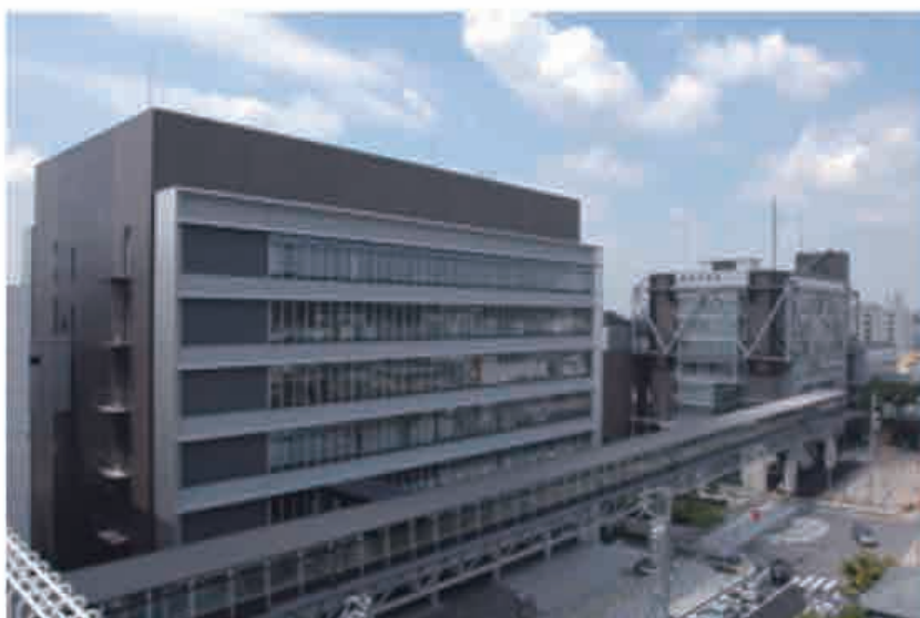
電力供給先の1つである「岡崎市役所本庁舎」
