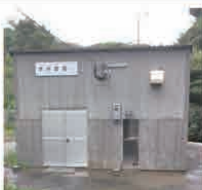
永吉川水力発電所
