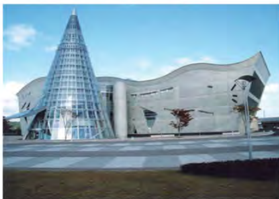
文化会館（アンパーホール）
