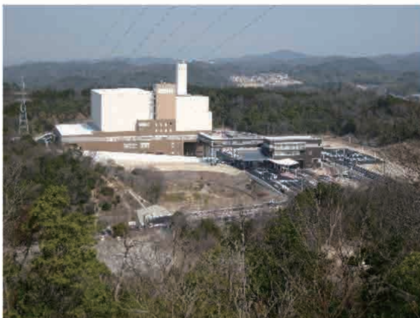
調達電源の1つである「中央クリーンセンター」
