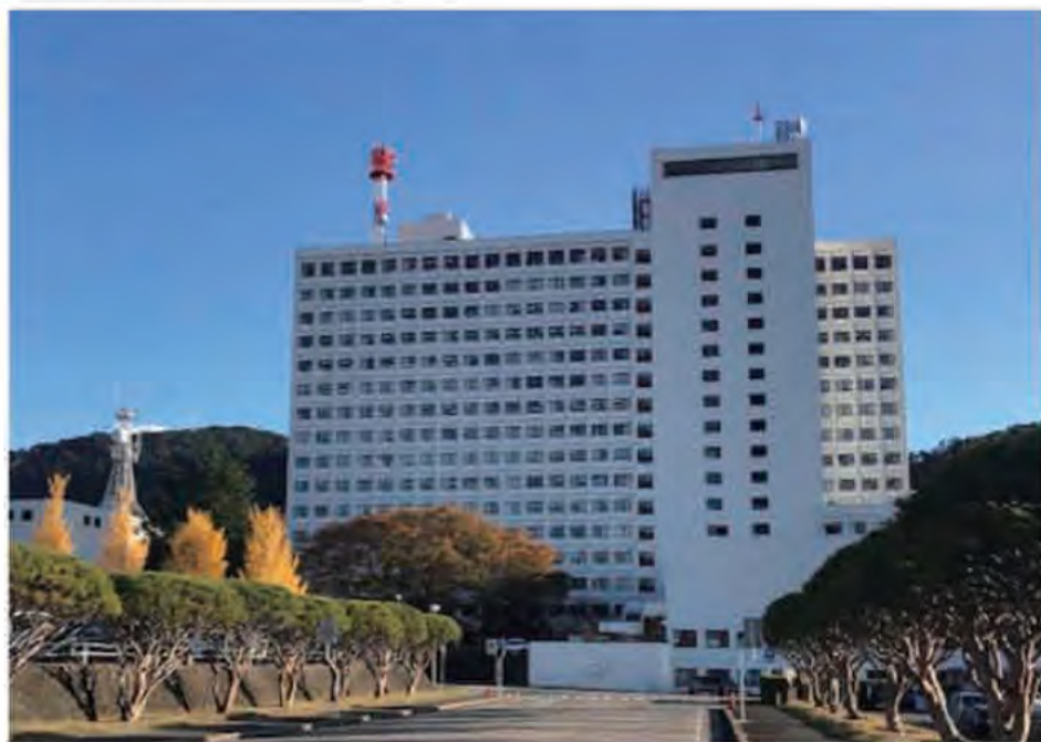
電力供給先の県有施設
