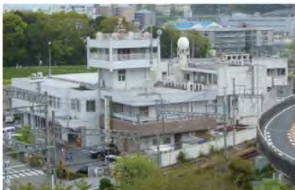
主な電力供給先の三郷町役場庁舎
