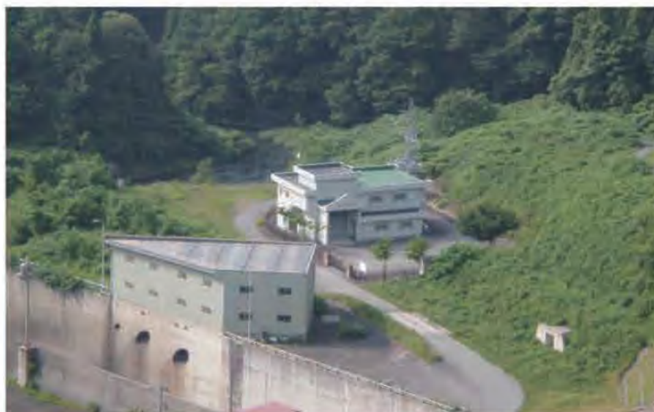
調達電源の一つである県営鶴子発電所
