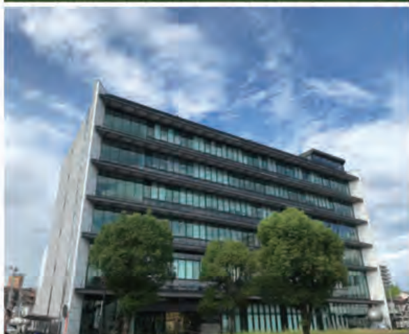
左上: 西部環境工場(ごみ発電)、 右上: 東部環境工場(ごみ発電)、 左下: 大型蓄電池を設置した上下水道局庁舎
