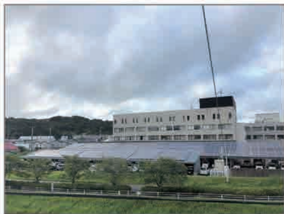
コンパクトグリッド行政エリア太陽光発電所
