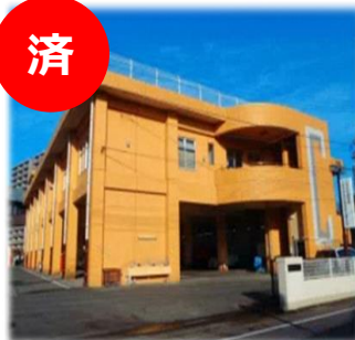
環境部庁舎（竣工1990年）
