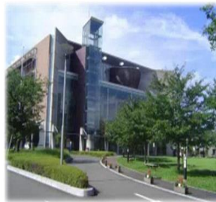
えーるピア久留米（竣工2000年）
