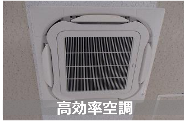
【空調設備の更新】
