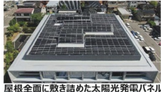
屋根全面に敷き詰めた太陽光発電パネル
