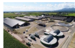
上士幌町の乳牛ふん尿を活用したバイオガスプラント
