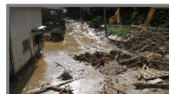
令和6年9月20日からの大雨 珠洲市の河川土砂堆積現場 (提供：石川県HP)
