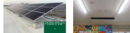
すずらん台小学校の太陽光、ガスヒートポンプ空調 写真：名張市
