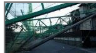
令和元年台風15号 千葉縣市原市の倒れた鉄柱 (提供：千葉県、市原市)
