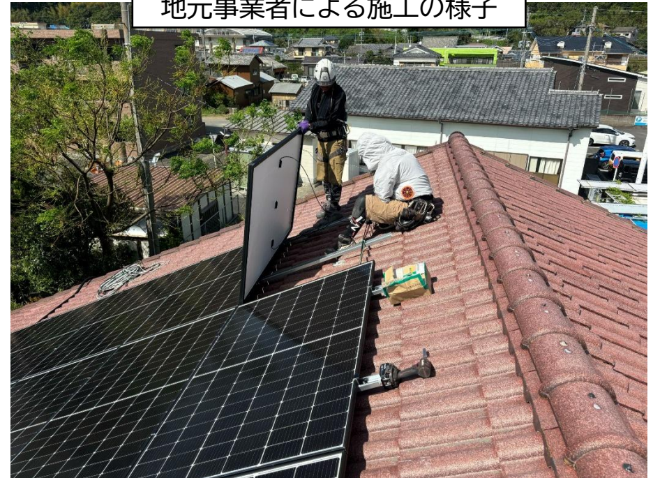
地元事業者による施工の様子
