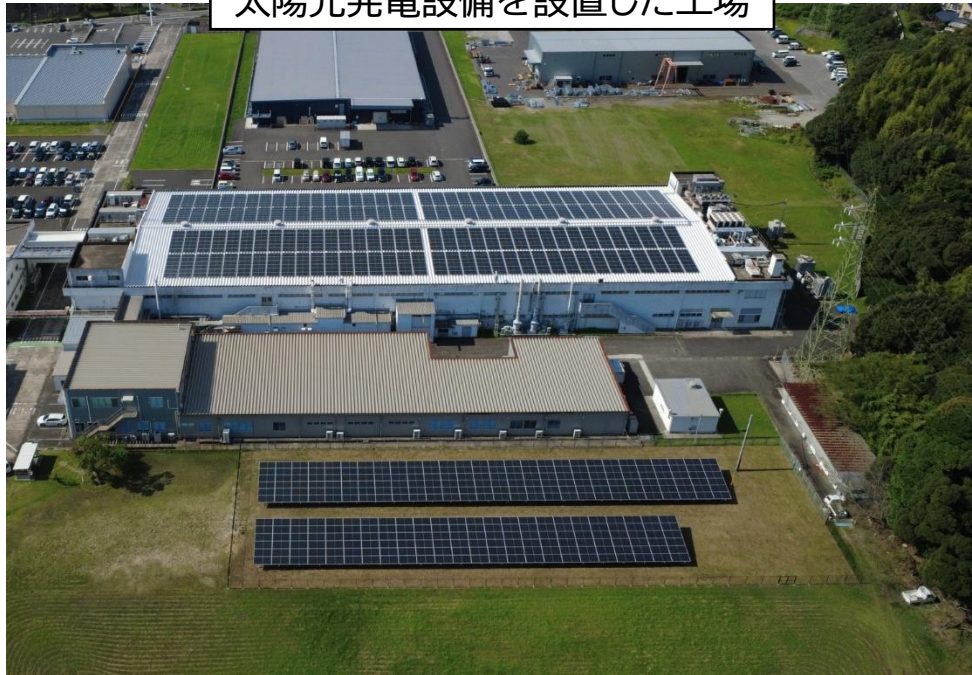
太陽光発電設備を設置した工場
