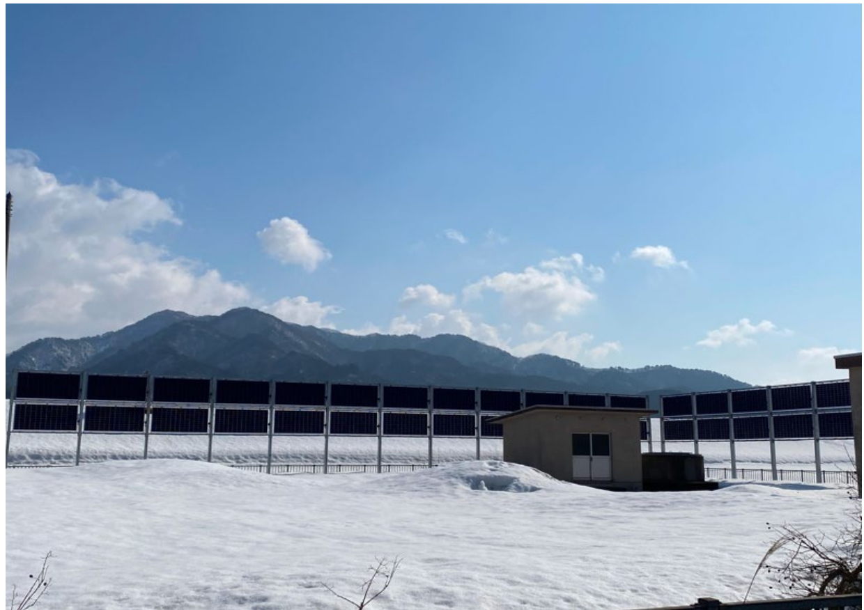
⑩関川村広域簡易水道水源地(垂直両面型太陽光発電)
