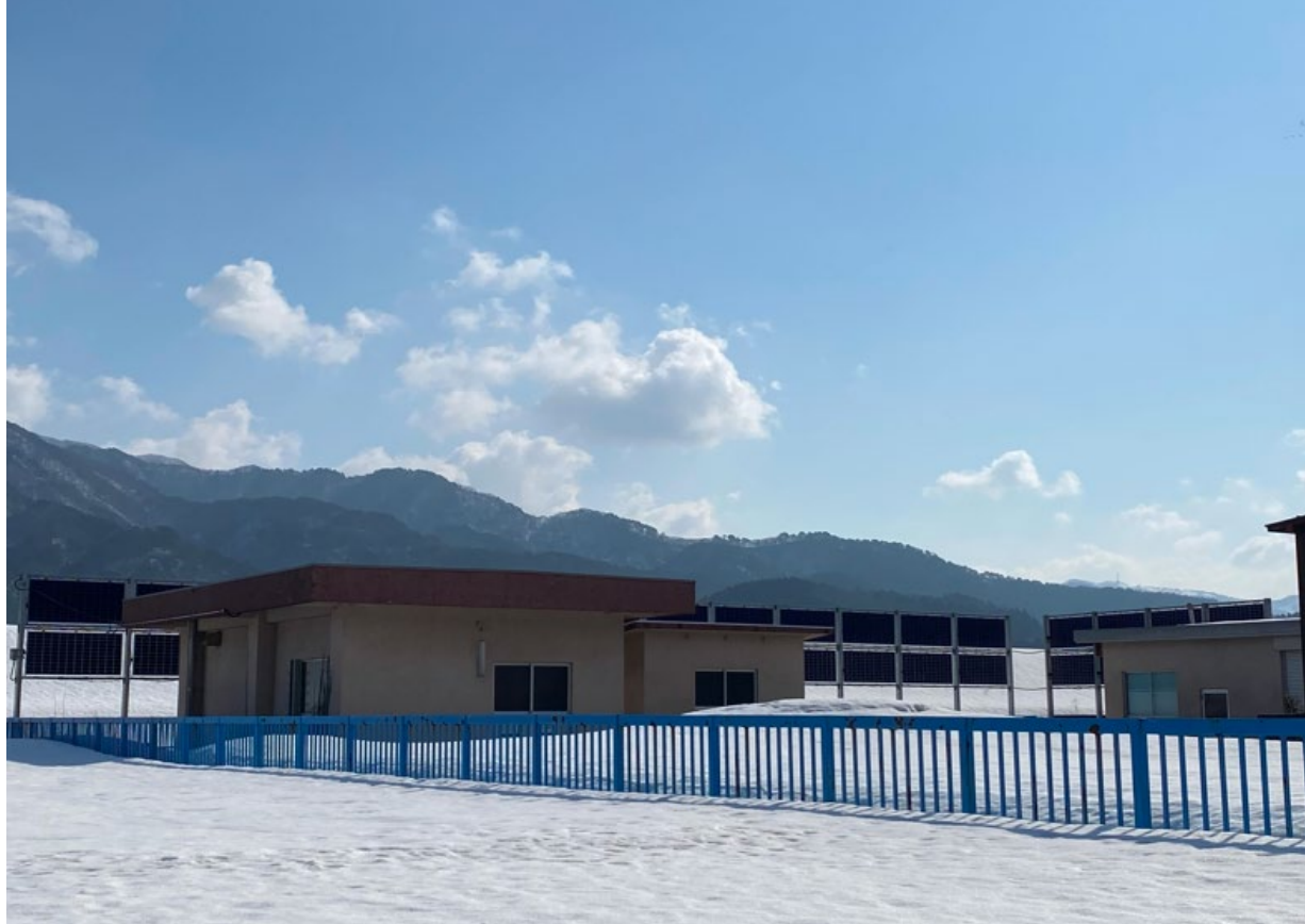
⑩関川村広域簡易水道水源地(垂直両面型太陽光発電)
