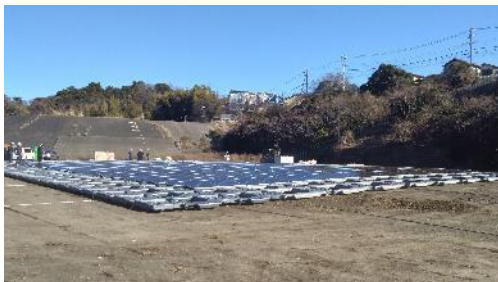
調整池のフロート太陽光発電
