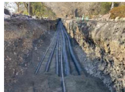
地域マイクログリッド構築工事
