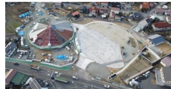
融雪設備等を導入する道の駅（建設中）
