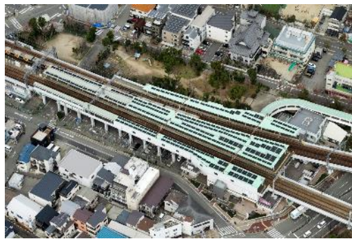
大物駅に導入された太陽光発電
