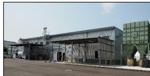
もみ殻ボイラ棟
