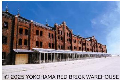
太陽光発電の余剰電力が供給される横浜赤レンガ倉庫
