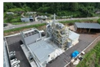
バイオマス発電所
