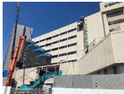
解体中の旅館
