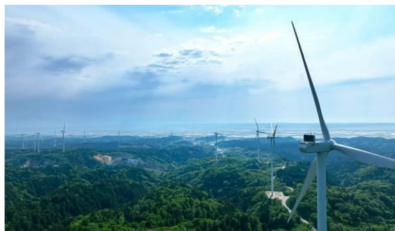
図 中里風力発電所
