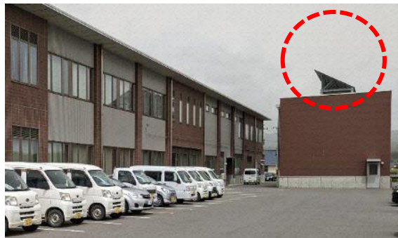
図 公用車車庫屋上の太陽光発電設備
