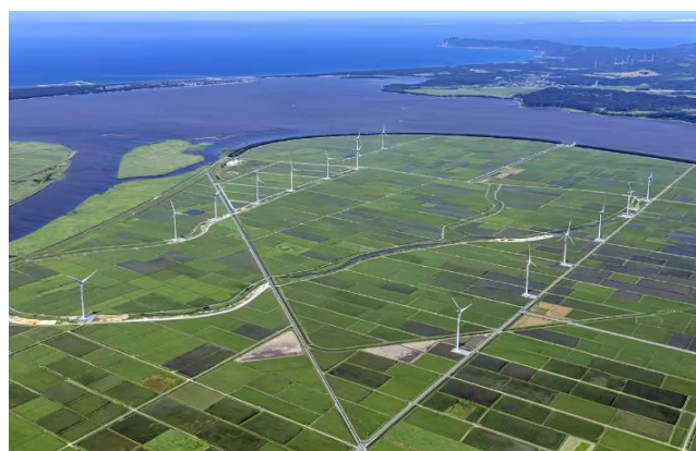
図 地域エネルギー会社と電力供給契約済のHSE株式会社が運営する十三湖風力発電所
