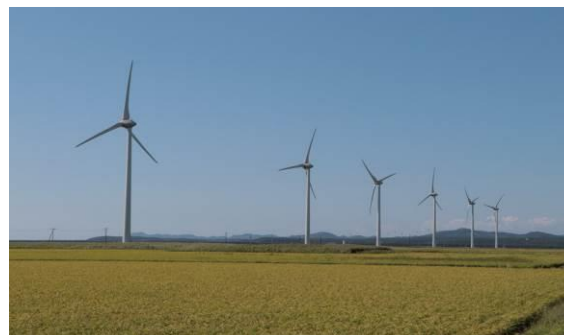
図 十三湖風力発電所
