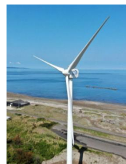
図 中型風力発電 (0.33MW)
