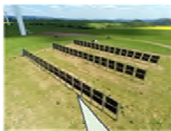
垂直ソーラーの導入。早朝・夕方の搾乳等の電力需要に対応
