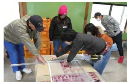
建具断熱に使う材料をカット
