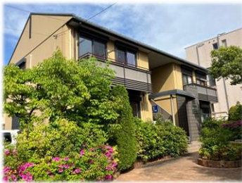
断熱改修を行う 既存賃貸集合住宅
