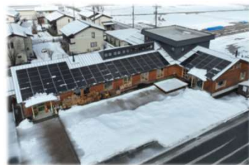
融雪機能付き太陽光パネル
