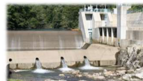
町営小水力発電所
