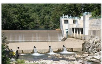
町営小水力発電所
