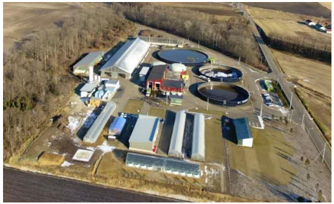
図9 中鹿追バイオガスプラントの状況
