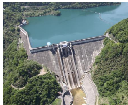
県内の水力発電所
