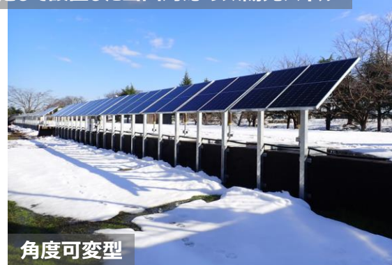
公共施設に実証実験として設置した雪国対応の太陽光パネル
