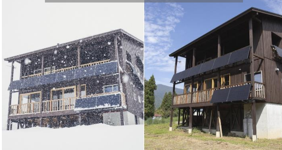
雪国型太陽光発電設備（例：壁面斜め置き型）
