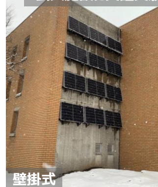
公共施設に実証実験として設置した雪国対応の太陽光パネル
