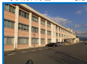
郡山総合庁舎の『ZEB』化
