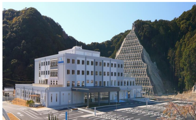
令和6年度に太陽光発電設備を導入予定の町立病院
