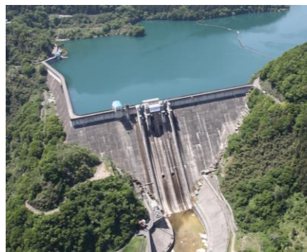
県内の水力発電所
