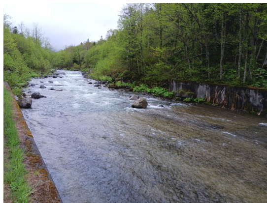
小水力発電導入（取水）予定地
